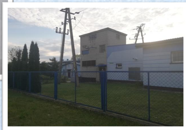
Stacja Uzdatniania Wody w Hajnówce
